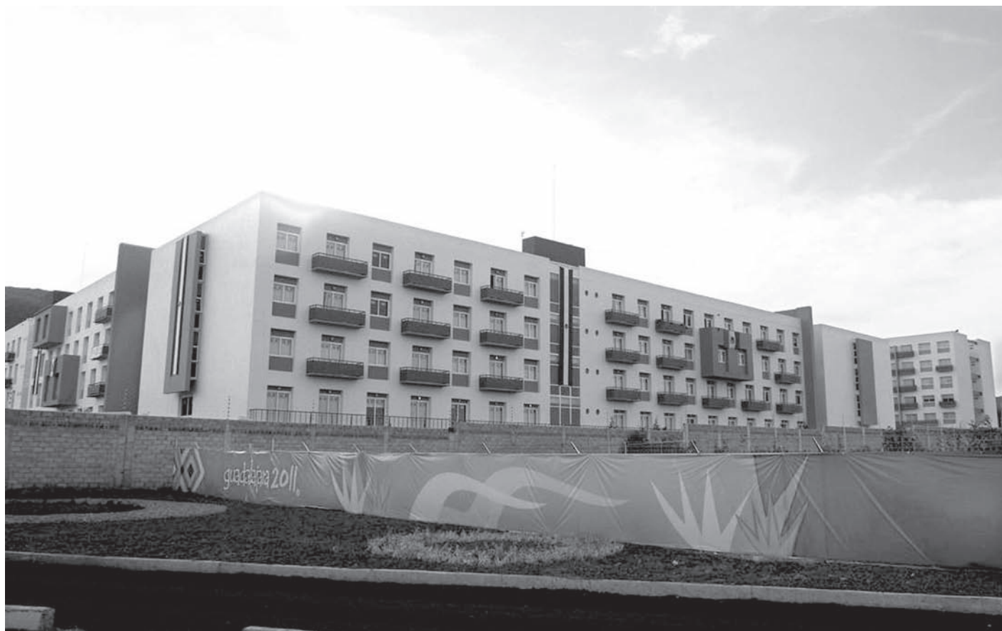
La Villa Panamericana está en medio de una polémica generada por el desagüe de aguas negras en una área ecológica. Foto: www.flickr.com
